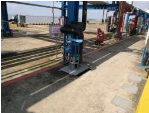
码头平台集水池1
