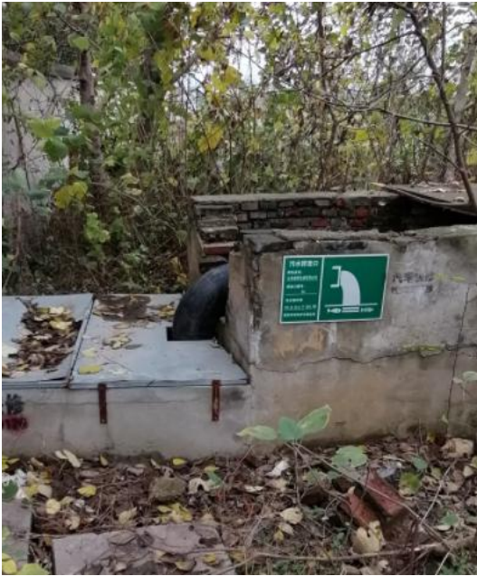
废水排放口标识牌
