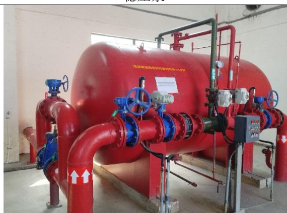
压力比例式泡沫装置
