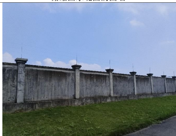
储罐区西北面的围墙
