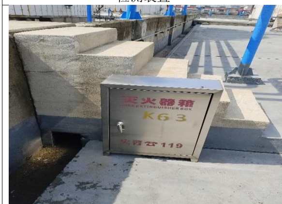
罐组内的灭火器箱
