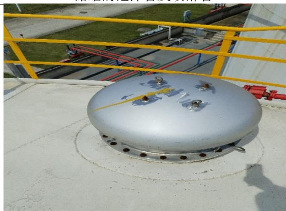
储罐的紧急泄压阀
