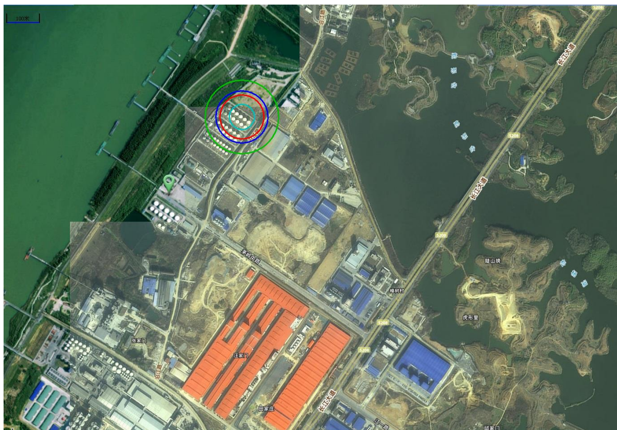
图 5.11-9 3000m 3 储罐甲苯容器整体破裂事故后果图
