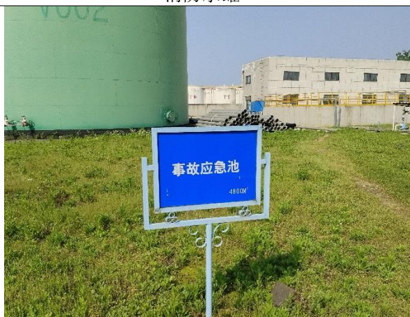
埋地事故应急池
