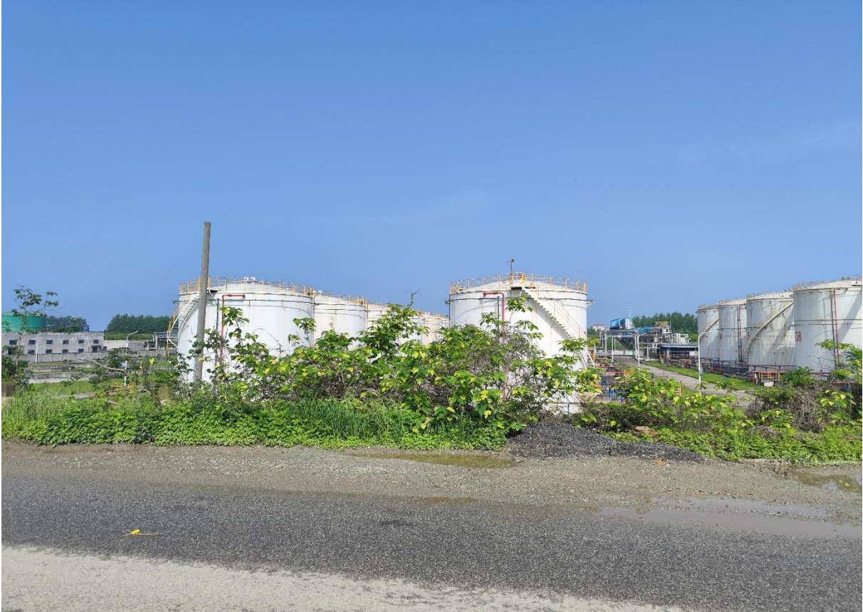
图 2.4-11 在沿江路上拍摄库区的照片
