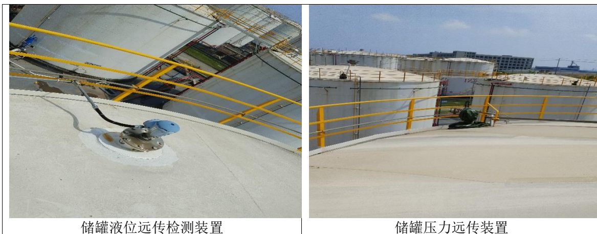
图 2.11-1 罐组区安全设施照片
