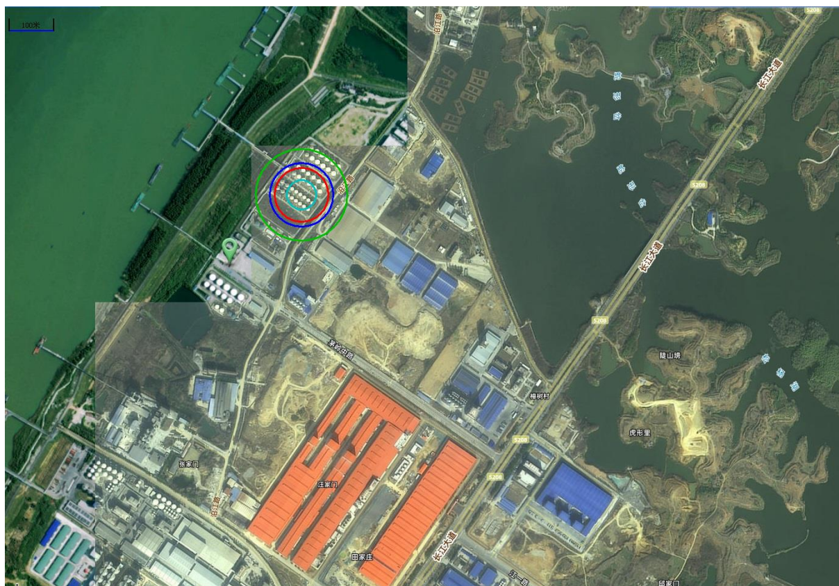
图 5.11-11 1000m 3 储罐甲苯容器整体破裂事故后果图
