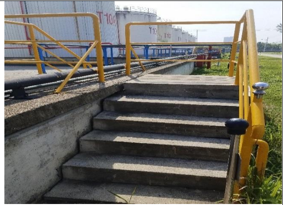
进入罐组的人行台阶及静电导除装置
