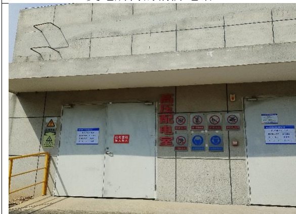
变电所外的安全警示标识
